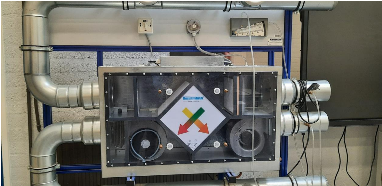
Hoe werkt een warmtewisselaar
