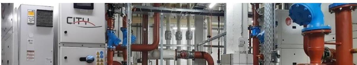
Lucht-water warmtepompen met groot buffervat voor veertig graden
