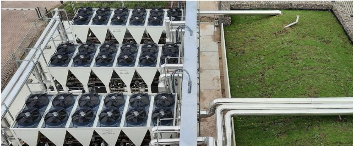
Lucht-water warmtepompen met groot buffervat voor veertig graden
