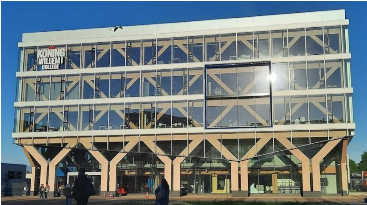
De duurzame, circulaire, flexibele nieuwbouw met grasdaken, zonnepanelen, sheddaken, klimaatplafonds, vloerverwarming etc.
