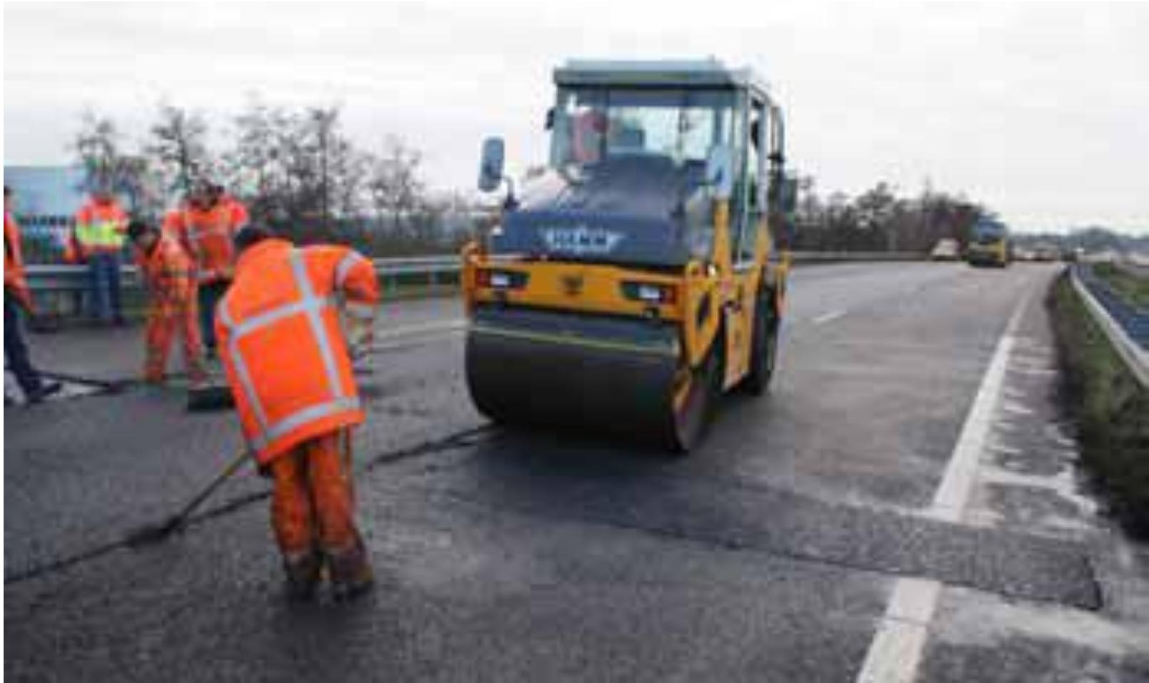
Asfalt met 1 cm staalvezels. Met een spoel kan het asfalt zo tot 60 - 70 °C verwarmd worden waarna het vloeibaar wordt en scheuren dichtvloeien.
